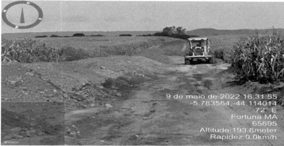
Estrada sendo executada
