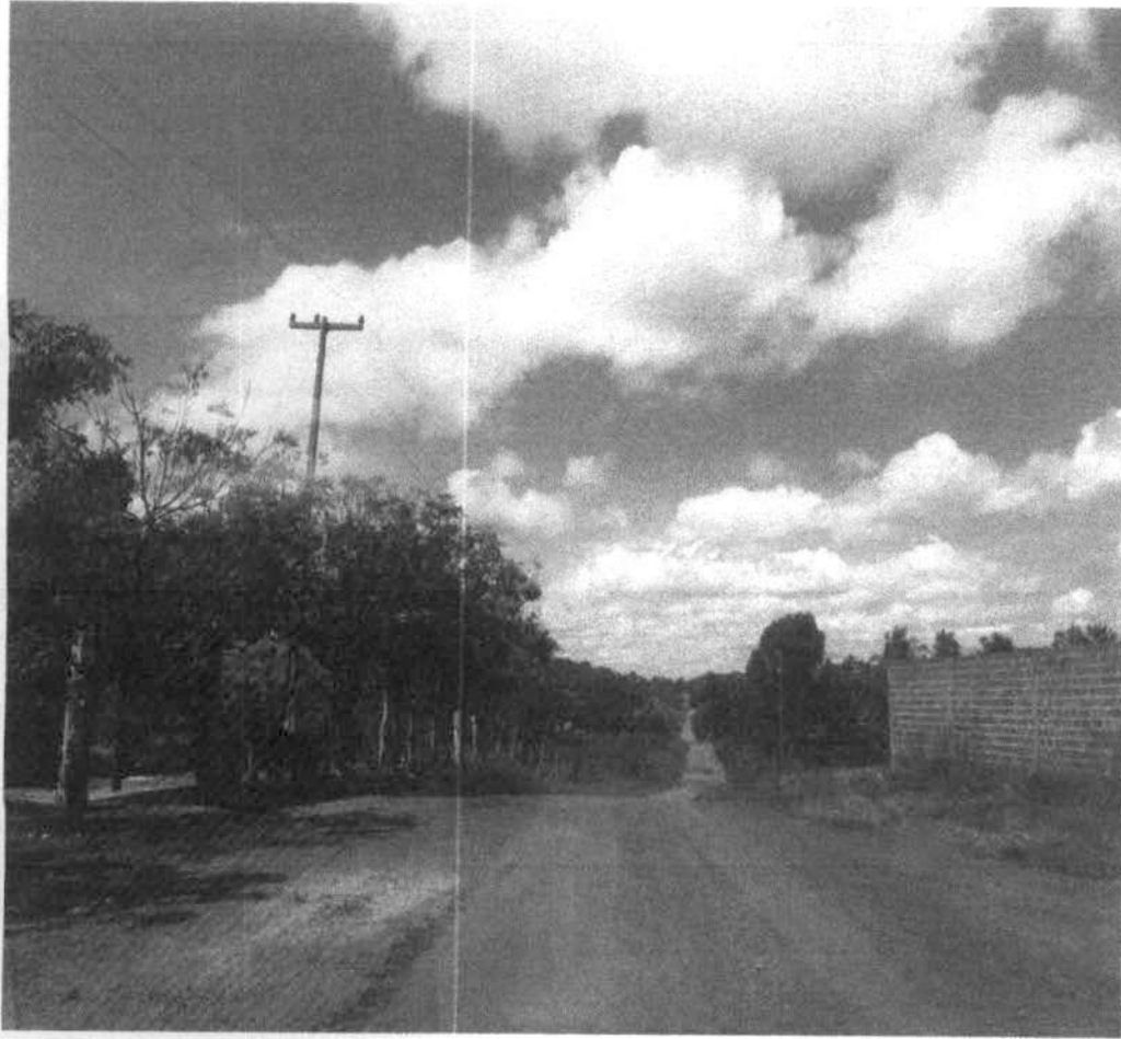
Trecho executado ligado entre a MA-034 e ao povoado gato zona rural de Passagem Franca-Ma.
