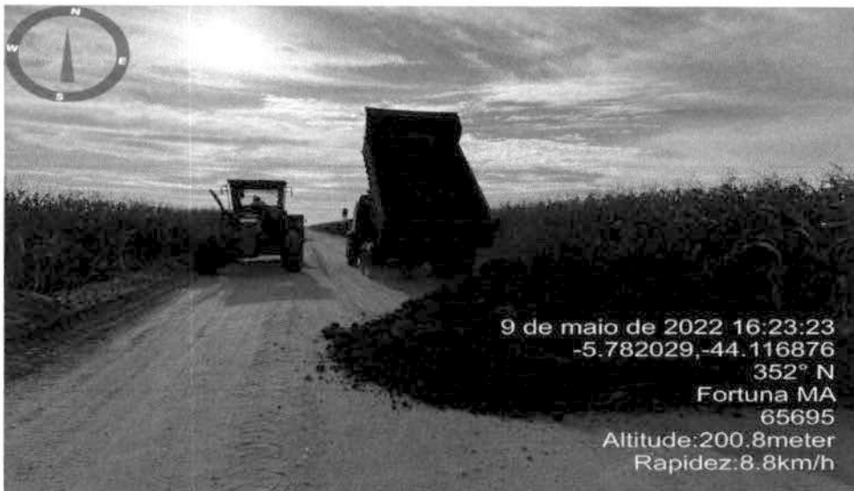
Estrada sendo executada
