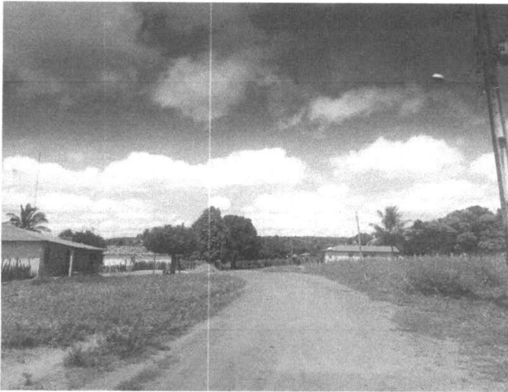
Trecho executado povoado gato zona rural de Passagem Franca-Ma.
